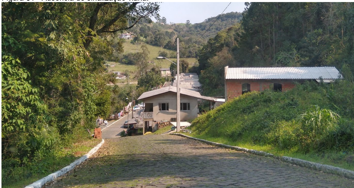
Figura 61 - Ausência de sinalização viária.
